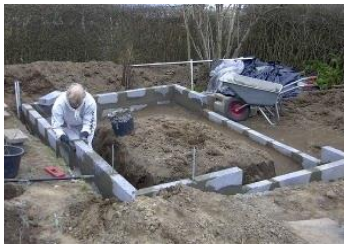
Fundament med lecablokke. En 7 cm bred blok er tilstrækkelig. Bemærk de lange stålstænger. Gengivet med venlig tilladelse af Susanne Irming. http://susannes-blomster-cafe.dk/
