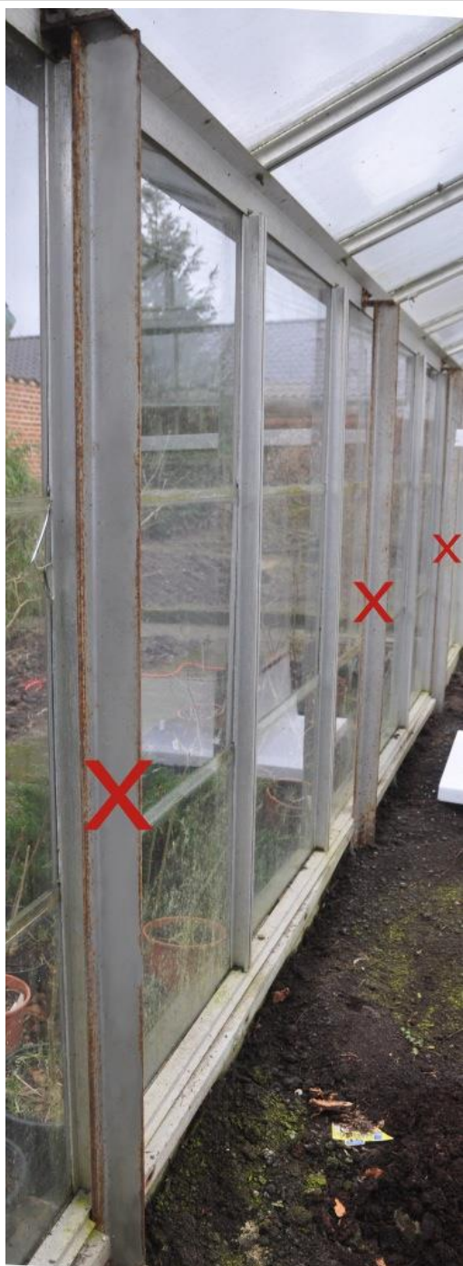
Tre T-stålprofiler i hver af drivhusets langsider stabiliserer ekstremt godt.
