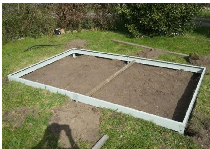
Her ligger stålsoklen på jorden og er ved at være klar til nedstøbning. Gengivet med venlig tilladelse af Mik. Kongsfelt, http://madhaven.dk/f
