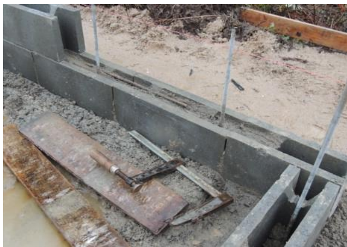
Fundament med fundablokke. Den smalle udgave på 15 cm er tilstrækkelig. Bemærk de lange stålstænger. Gengivet med venlig tilladelse af John Carlsson, http://huset.carlssons.dk
