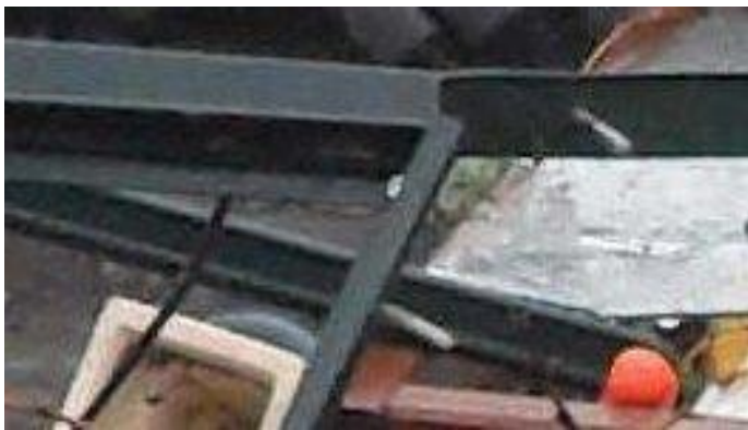
Forstørret område nær vandhanen på billedet, side 1. Heraf ses, at skruerne er rykket op af soklen, der er fremstillet af træ.
